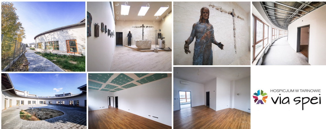
Hospicjum Via Spei – aktualny stan budowy
